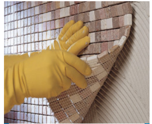
Assentamento de pastilha de mármore 2x2 em parede
